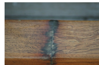
Рисунок 54 - Факторы ухудшения из-за влажности
